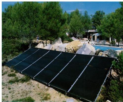
Les structures de support des panneaux peuvent être fournies sur mesure par ETM en fonction de votre projet. Chaque installateur peut également choisir de travailler avec ses supports et systèmes de fixation habituels, sachant que les panneaux utilisés sont souples, légers et résistants, de nombreux systèmes peuvent être utilisés.
