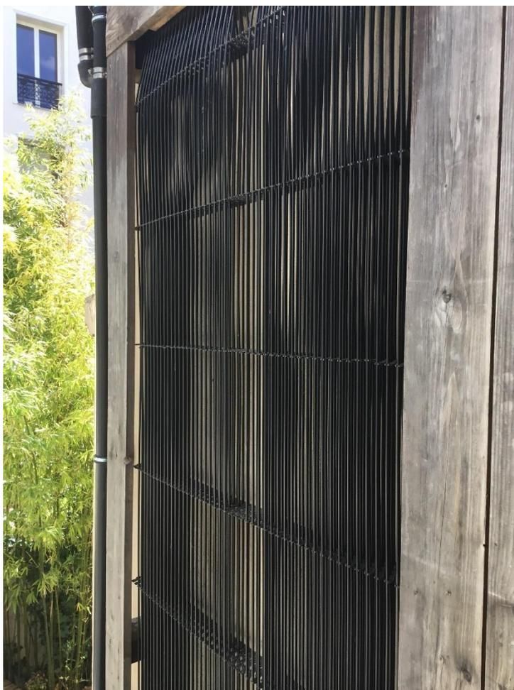
Les capteurs atmosphériques 4N permettent de récupérer dans l'air ambiant de la chaleur ou de la fraîcheur pour votre pompe à chaleur ou votre process. Ils captent aussi l'énergie solaire avec un très haut rendement.
